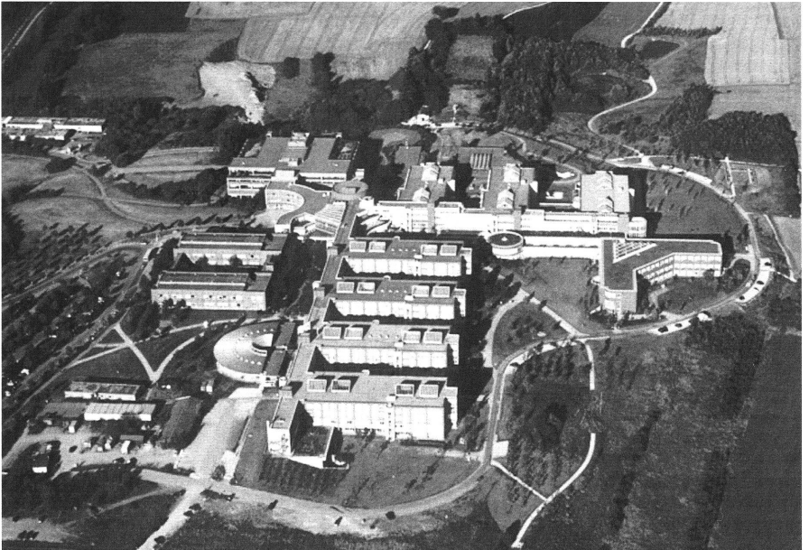
Gesamtansicht der Universität und des Klinikums Stand Dezember 2001
